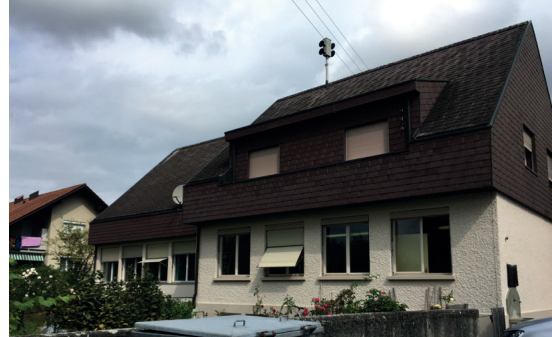
Schulhaus Schalunen von 1978
